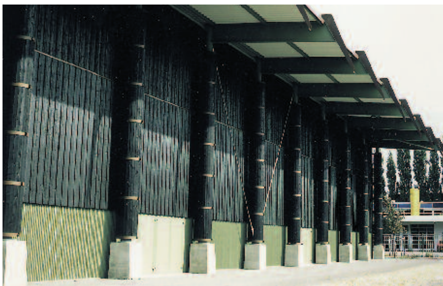
La Halle des Peupliers, une salle polyvalente implantée en zone inondable. Source : SEARL Beaudouin-Engel Architectes
